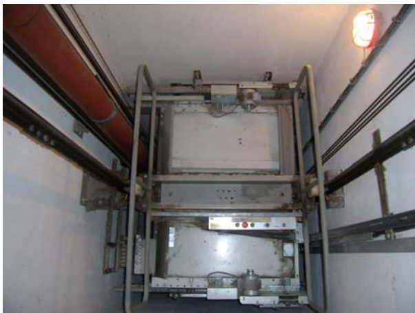
Pohled do šachty – strop kabiny a vlevo píst
