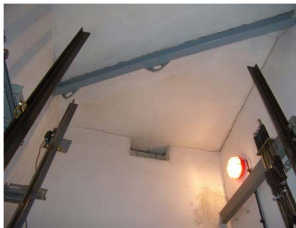
Hlava šachty s montážním nosníkem a větr. Mřížkou
