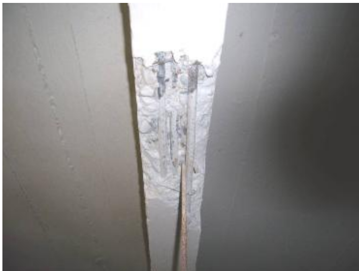
Sonda V6, výztuž 3Ø18
