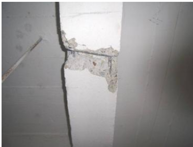
Sonda V4, výztuž 2Ø14
