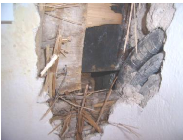
Sonda VI, odkrytý ocelový nosník
